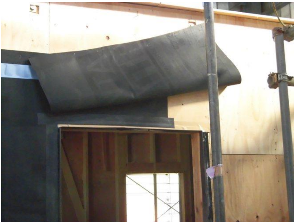
11. 窓の上の二重の防水処理完了。
