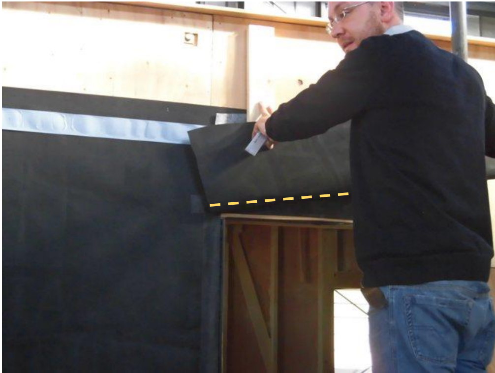
10. この時、折り返し線が少し斜めになるようにします(約 10^{\circ} )。
