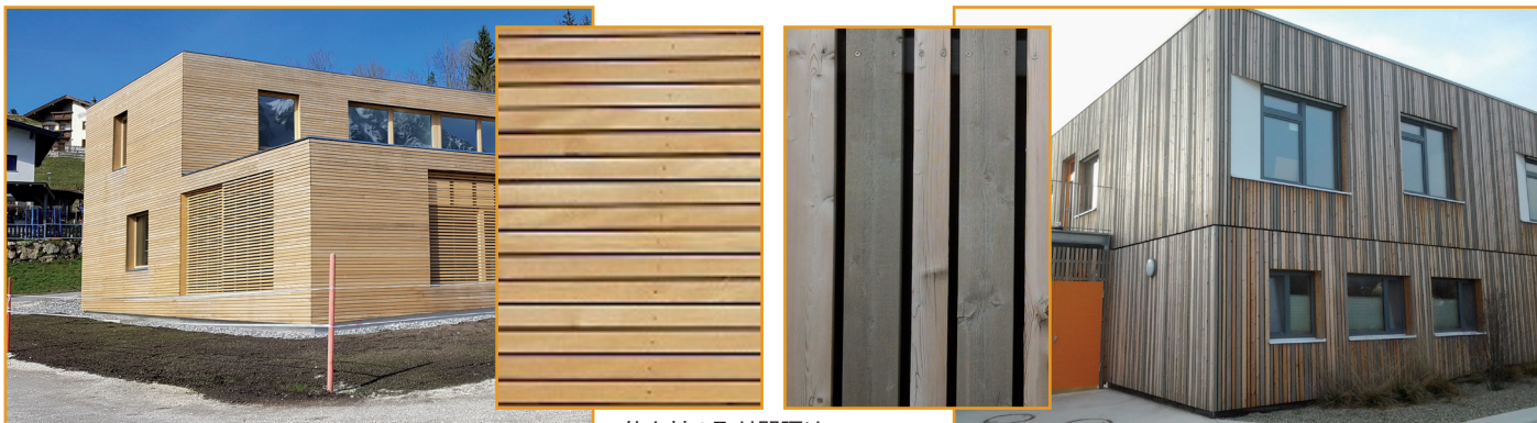
仕上材の取付間隔は10~25mm
