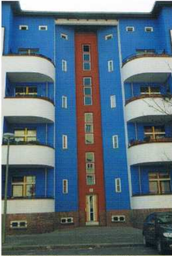
写真21 ベルリン市シェーンラカー通りの集合住宅
