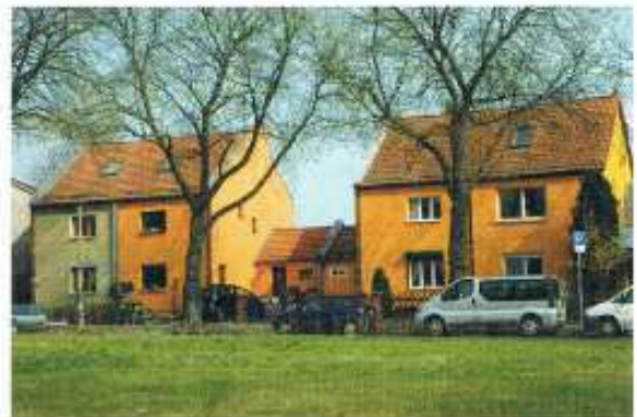
写真25 ベルリン市ホーエンシェーンハウゼンの小住宅
