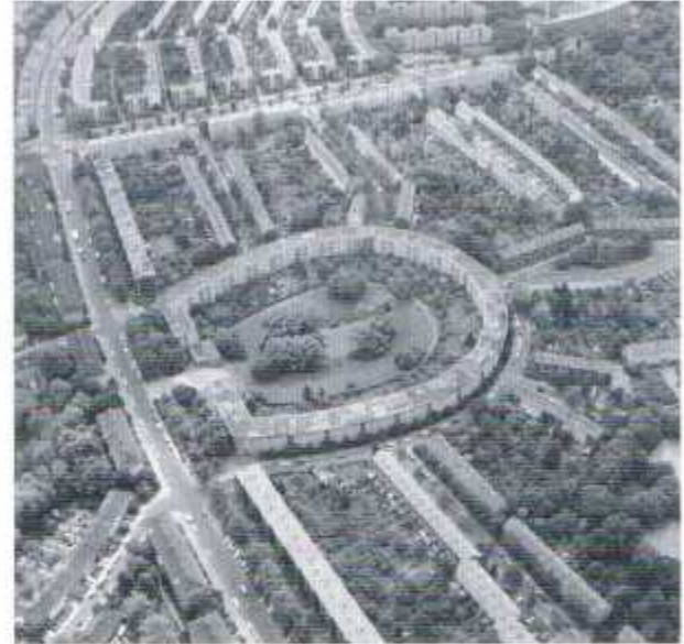
写真13 ベルリン市ブリッツの馬蹄形住宅鳥瞰写真
