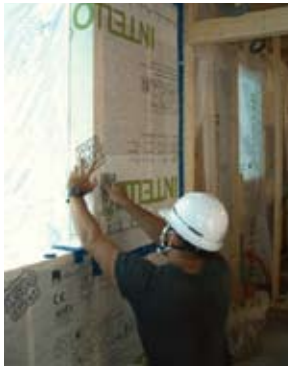
▲ Einbau von Intello - feuchtevariable Luftdichtung für alle Klimabereiche.
