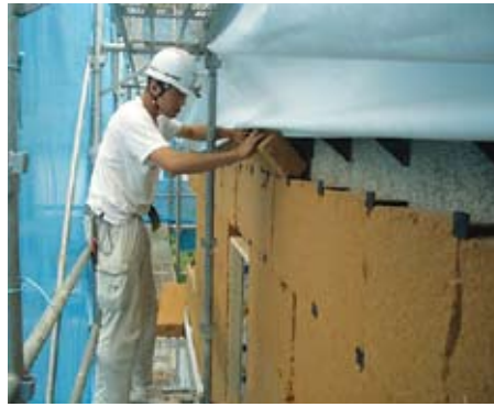
▲ Einbau von 100 Millimeter starkem Holzfaserdämmstoff Homatherm für die Außendämmung.
