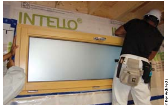
▲ Einbau eines dreifachverglasten Fensters in das Passivhaus Kamakura.
